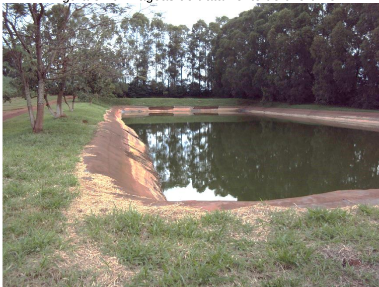
Figura 3.20 - Lagoas de tratamento de chorume
