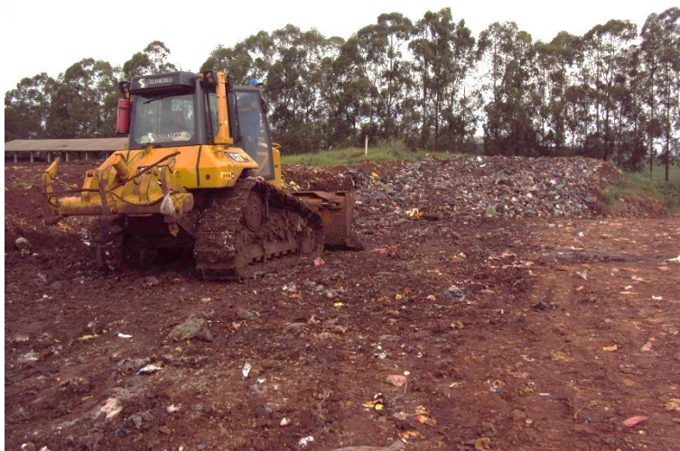
Figura 3.21 - Trator de esteira caterpillar fazendo espalhamento e compactação do resíduo
